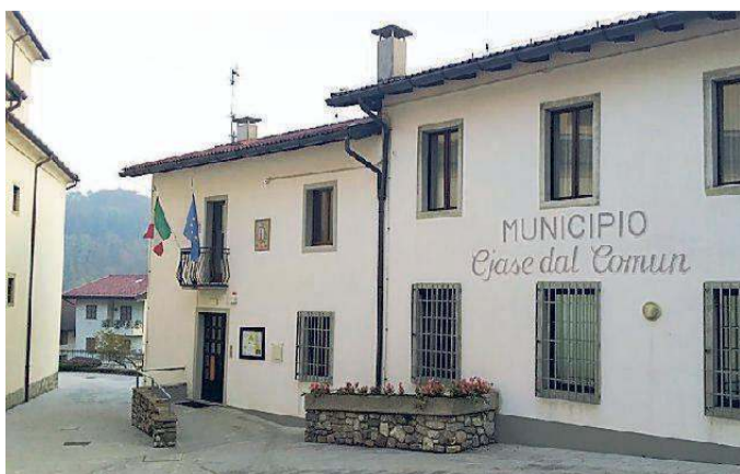
L'esterno del municipio di Raveo
